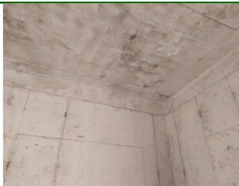
Laje armada contendo telas Q-138 com 4.2mm de diâmetro e concreto fck 20.
